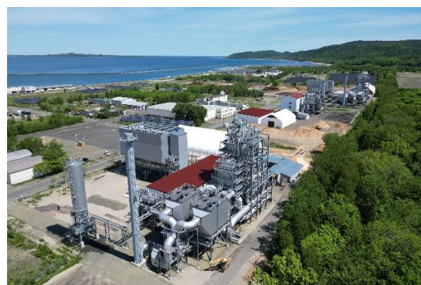
本発電所外観（手前：3号機、奥：2号機、2023年6月撮影）
